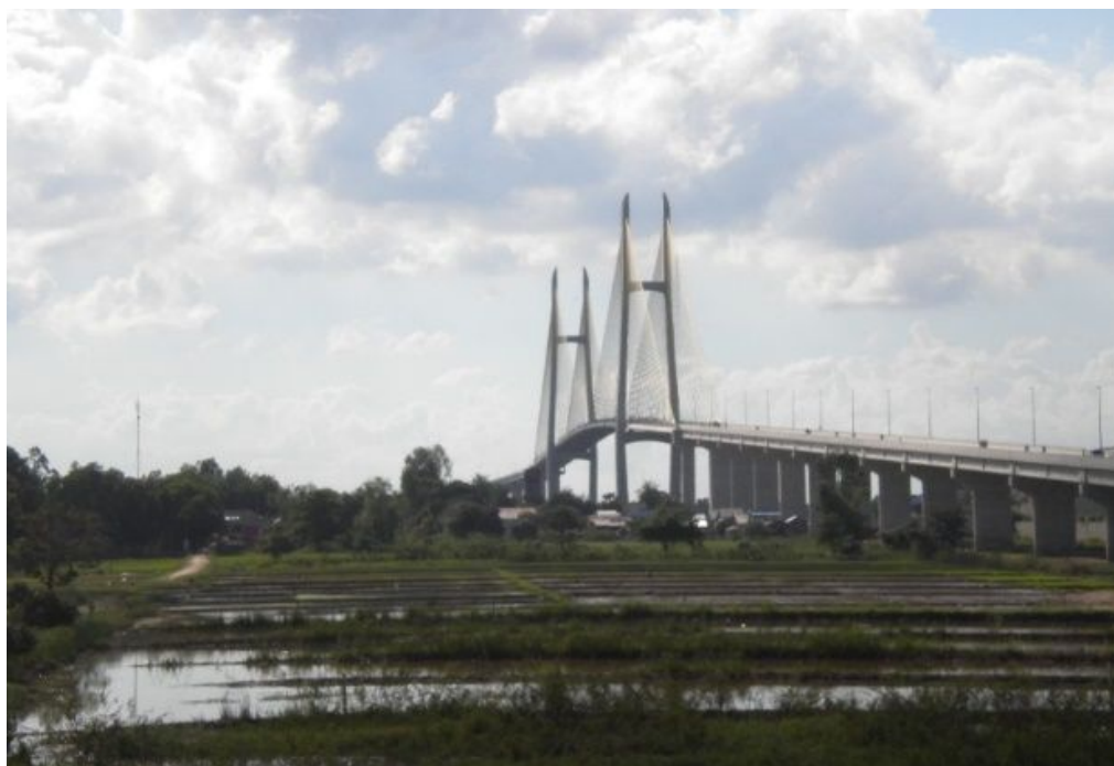
写真 ネアックルン橋
