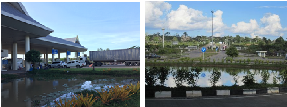
写真 第3 友好橋の施設
