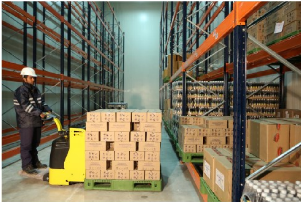
図表 インドの冷凍冷蔵倉庫②
