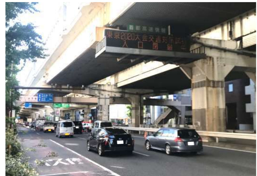
入口閉鎖（国道246号 三軒茶屋入口周辺）
