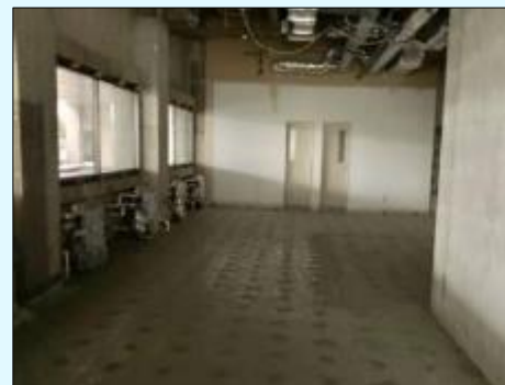
改修工事前（スケルトン）
