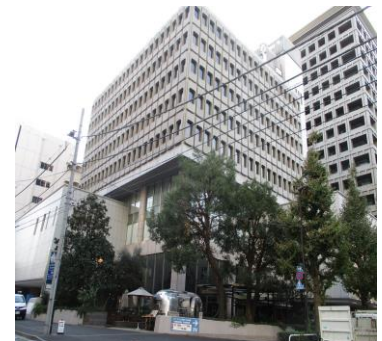
(写真：船協の入る海運ビル)
