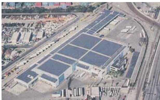
倉庫の全景。屋根には約7,600枚の太陽光パネルを設置。敷地面積22,075坪、収容パレット数26,000枚
