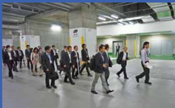
地下3階荷捌き場
