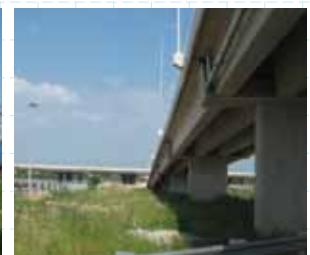
延伸中の高速道路 (ホーチミン)
