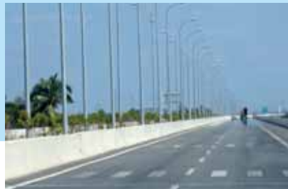
新規に開通した高速道路 (ホーチミン)
