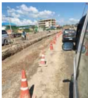
市内接続部の工事区間
