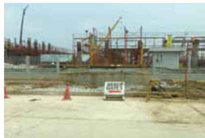
ジャカルタ東部工業団地では建設中の工場が目立つ
