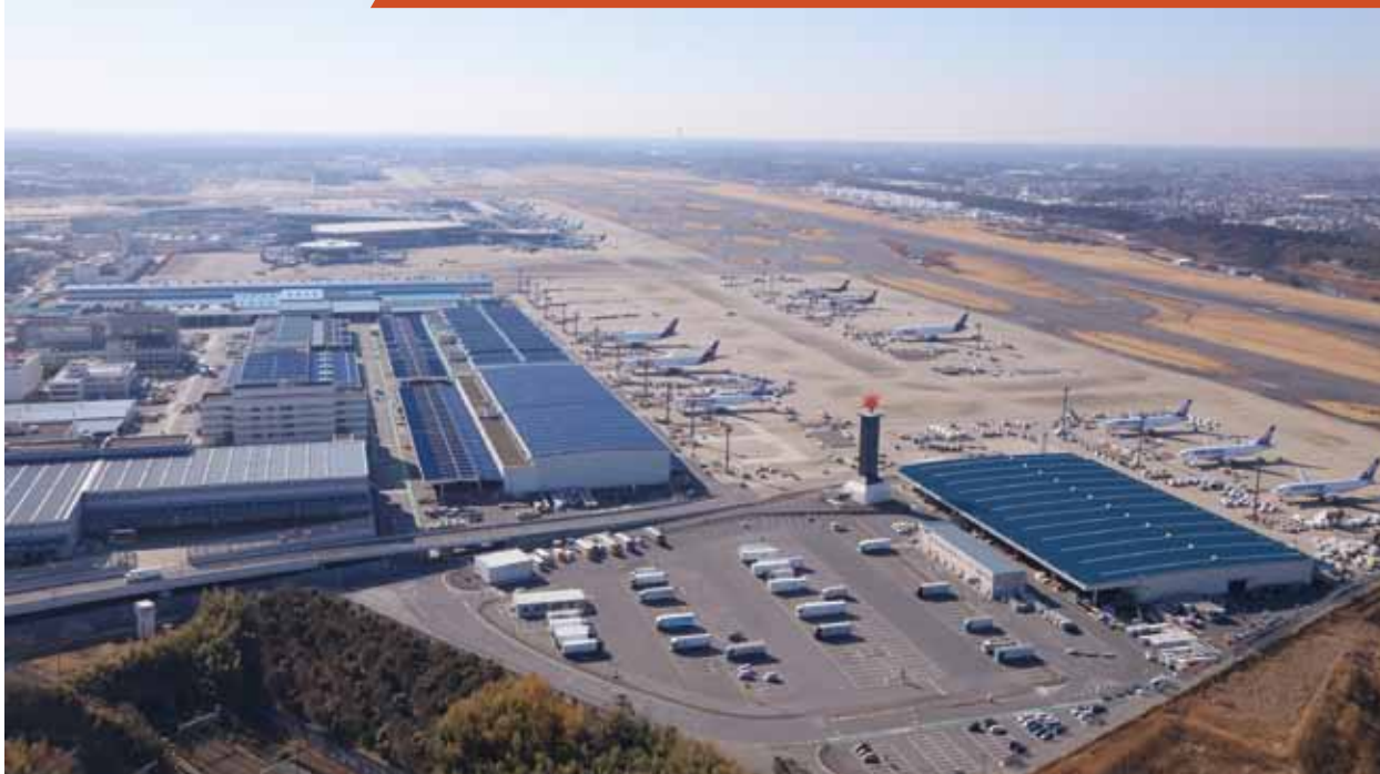
成田国際空港貨物地区全景 (提供: 成田国際空港株)
