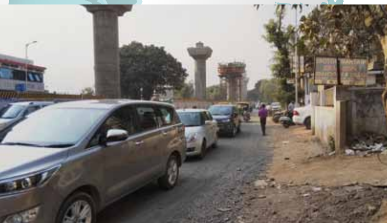
交通インフラの建設工事が進むアーメダバード
