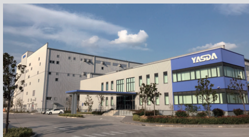
上海・青浦倉庫(安田物流(上海)有限公司)
